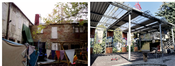
Der „Traumhof“ vor und nach der Sanierung
